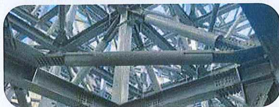
▲県庁の耐震構造 震災後に補強したそう
